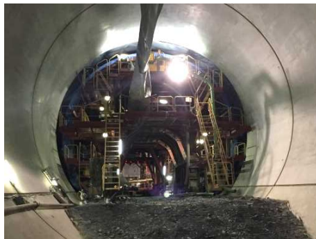
▲導流部で用いたスライドセントル
