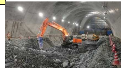
▲【下半部】発破+4.0級ブレイカーによる小割破碎状況
