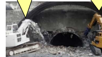
▲【上半部】4.0t級ブレイカーによる掘削状況
