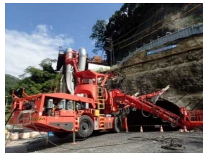
▲施工機械の事例(ドリルジャンボ)
