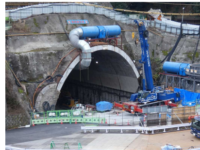
▲トンネル掘削状況
