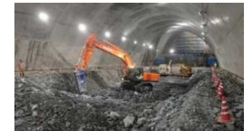
▲【下半部】発破+4.0級ブレイカーによる小割破碎状況
