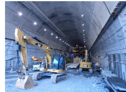
▲トンネル掘削状況
