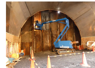
▲鋼管矢板切断(接続部側)
