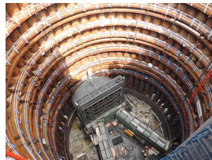
▲トランジション管設置状況
