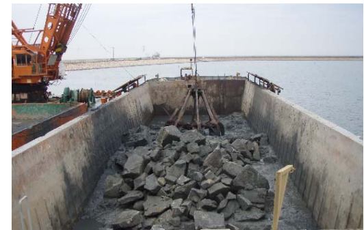
▲ (参考) 過去の捨石撤去状況写真
