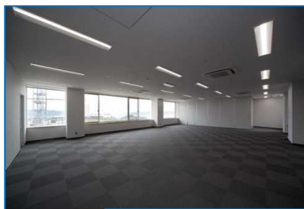
照明制御（1階事務室照明）
