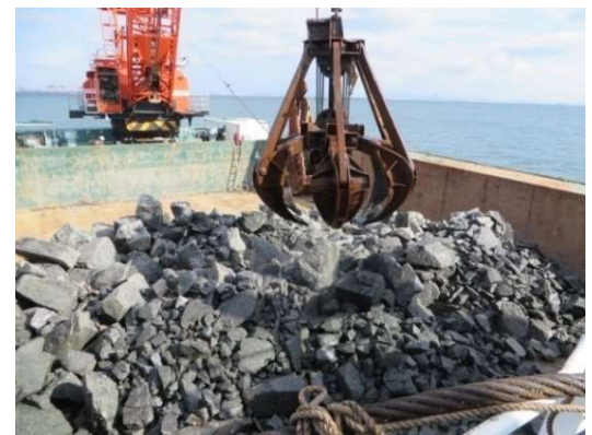
防波堤撤去で発生した捨石
