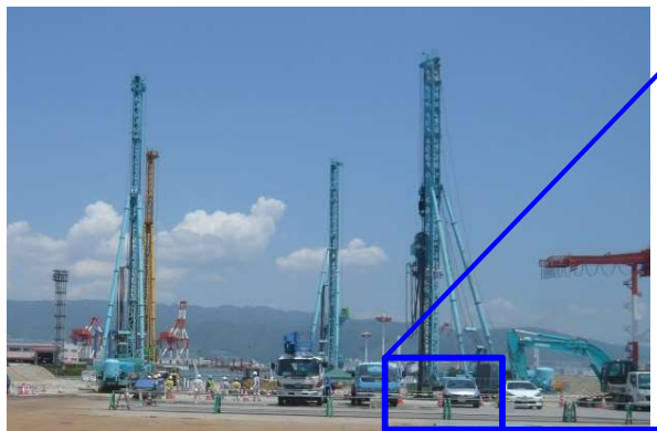
SCP工法による液状化対策工事
