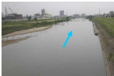
下流域のコンクリート護岸
