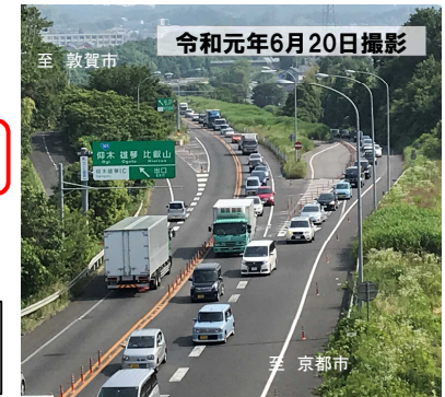
令和元年6月20日撮影 仰木雄琴IC付近の状況
