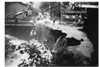
昭和56年7月洪水(梅雨前線) 旧足羽郡美山町の浸水状況
