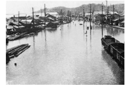
昭和28年9月洪水(台風13号) 福井市中央付近の浸水状況
