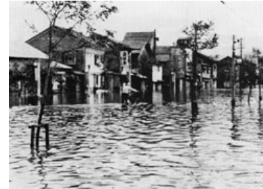
昭和28年9月洪水(台風13号) 福井市中央付近の浸水状況
