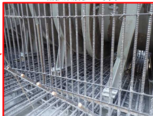
補強鉄筋拡大写真
