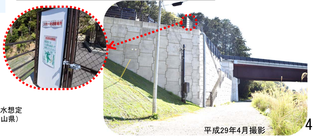
紀勢自動車道での避難路設置例(白浜町あたぎ地区)
