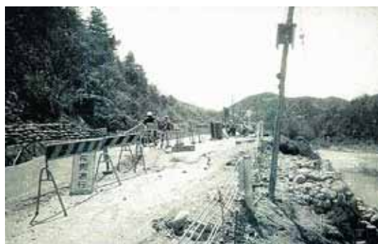
地すべり末端部に位置する国道25号の隆起による被害状況
