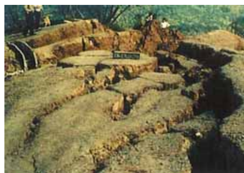
畑地の亀裂・陥没被害状況
