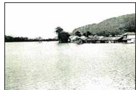
上流部の湛水被害状況(昭和6~7年)
