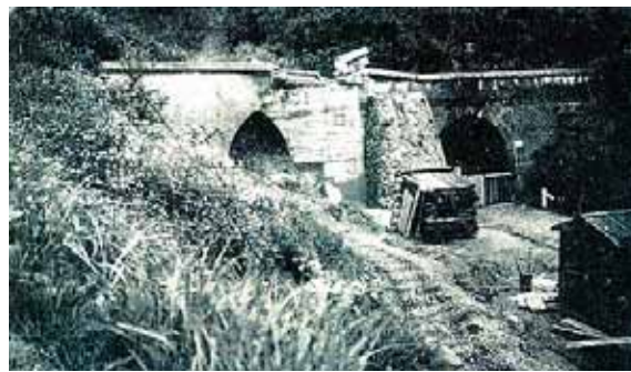
国鉄関西本線(現 JR)のトンネル崩壊
