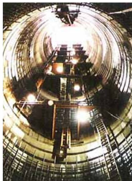
施工中の深礎工(直径 6.5m)の内部 (右)
