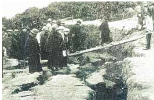
地すべりによる亀裂
