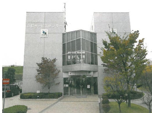
鳥飼サービスセンター（大阪府摂津市） 平成8年設置
