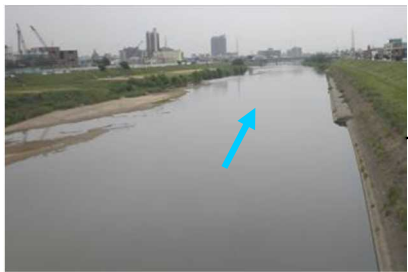
下流域のコンクリート護岸
