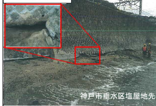
JR護岸状況
