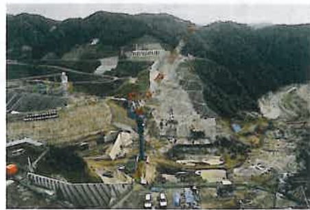
本体基礎掘削（平成6年）
