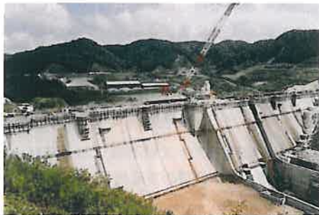
本体打設中（平成8年）
