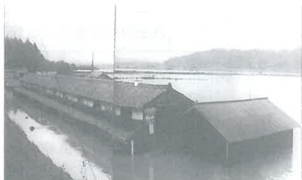
昭和28年13号台風による上野市内の浸水状況
