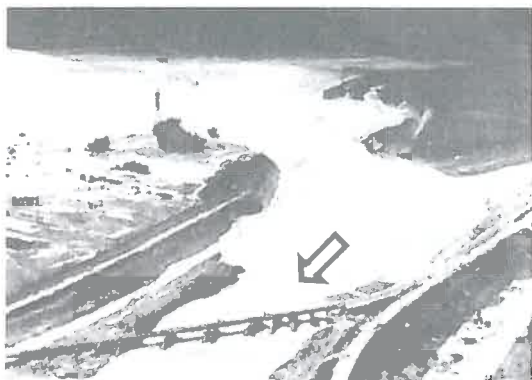
昭和28年13号台風による芥川の決壊状況
