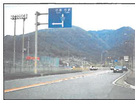
広幅員で安全性に優れたバイパス
