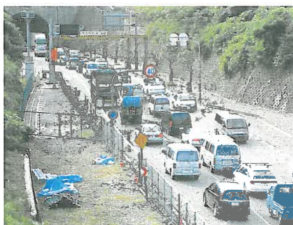
【②登坂車線合流部より奈良方面を望む】
