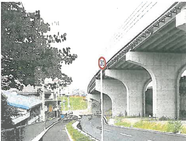
【②整備区間（遮音壁設置）】
