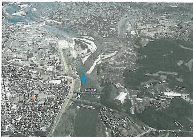
いわで 岩出狭窄部 (岩出井堰)
