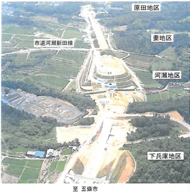
②橋本市河瀬地区付近 至 高野口町
