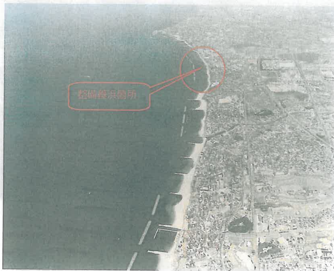
写真 6.3 養浜整備状況（撮影：平成 10 年 3 月）
