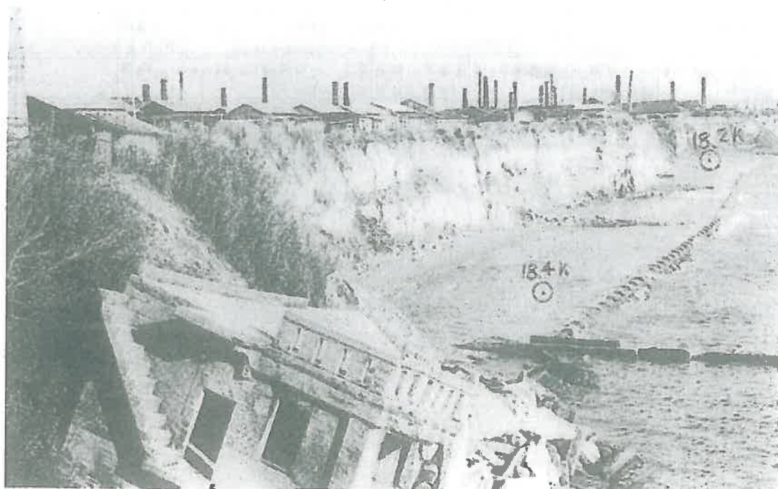
写真 3.1. 昭和39年頃に海岸の侵食によって崩落したタコ壺工場 (江井ヶ島地先)
