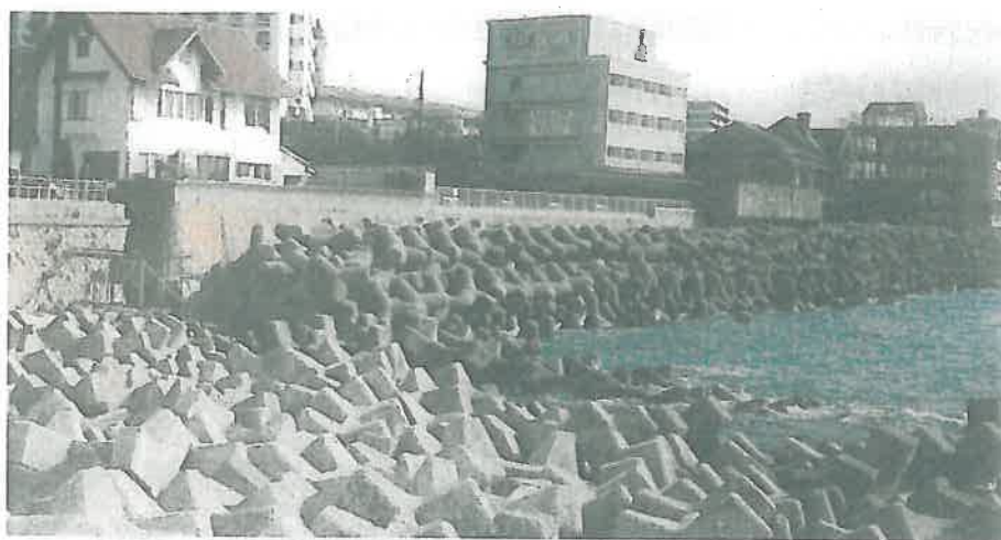
写真 3.4 アジュール舞子整備前
