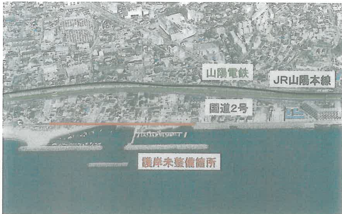
写真 6.1 護岸の未整備箇所航空写真（垂水工区）
