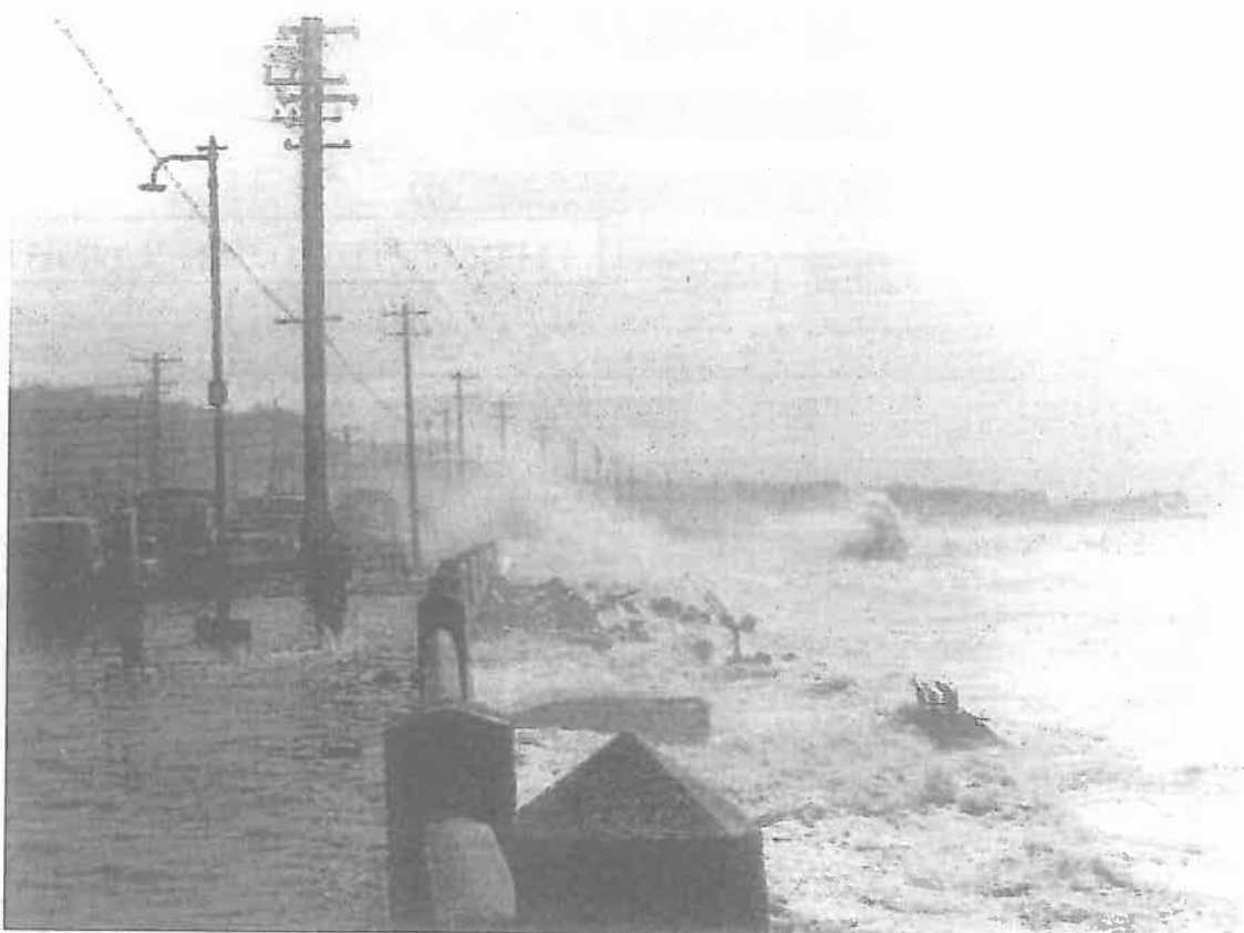
写真 3.2. 昭和39年台風20号による浸水状況（狩口地先）
