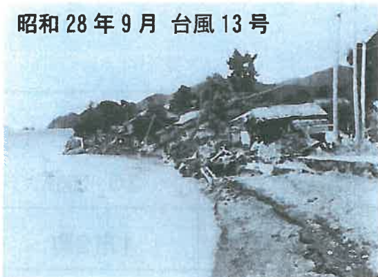
北川の氾濫により破壊された家屋
