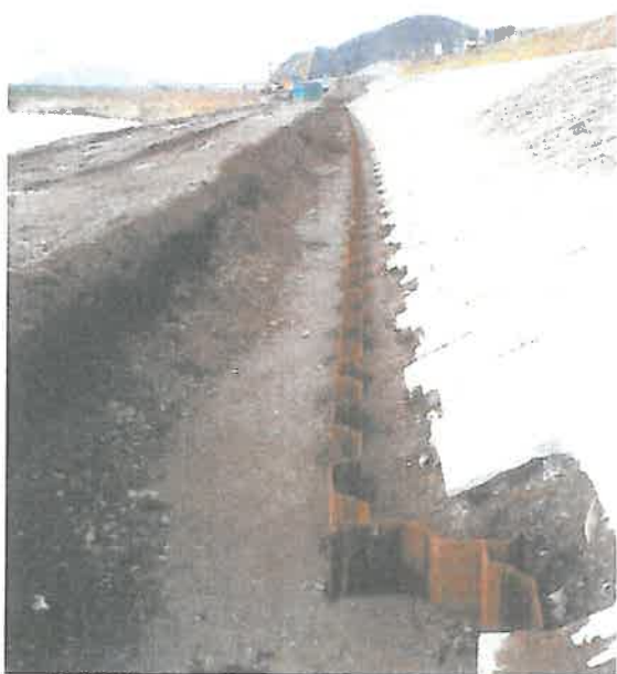
たかつか 高塚漏水対策工事 施行状況
