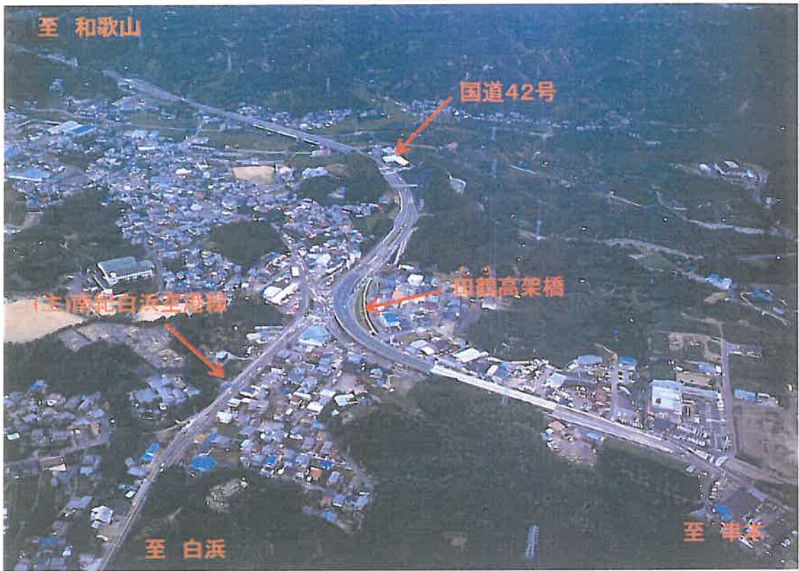
写真: 立体交差工事を進めている田鶴交差点周辺
