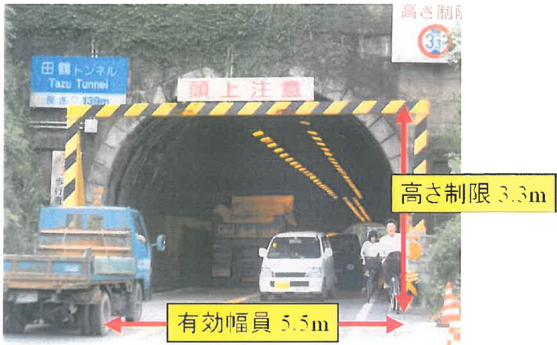
写真：現況における田鶴 たづ トンネルの有効幅員および高さ制限(田辺側より撮影) (自転車類交通量 720台, 歩行者交通量 50人(平成14年平日24時間調査結果))
