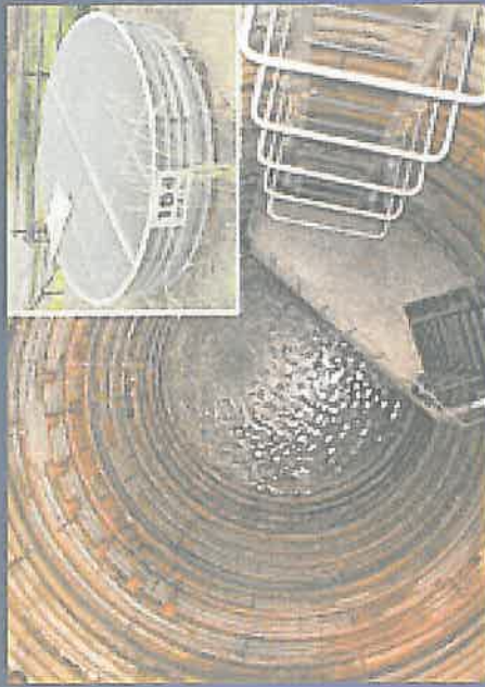
集水井工の内部 (右上は地上部の様子)
