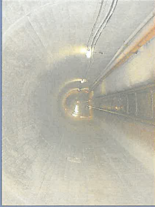
覆工後の内部（5号排水トンネル）
