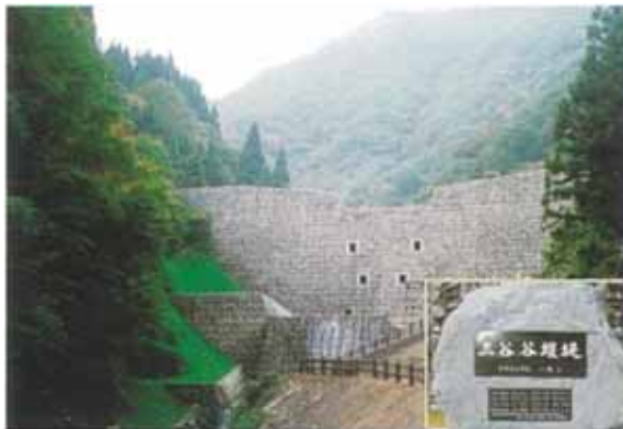
三谷谷堰堤(平成12年10月完成)
