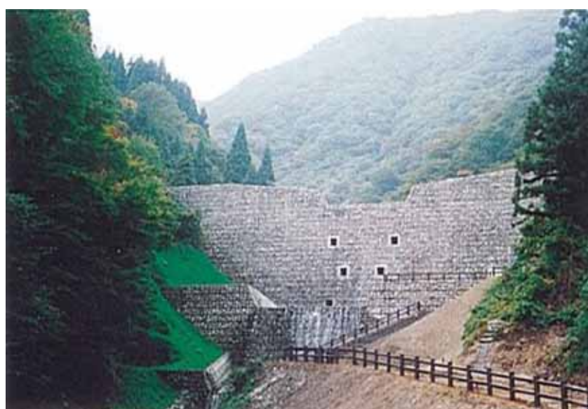
三谷谷えん堤 (植石ブロックによる修景)
