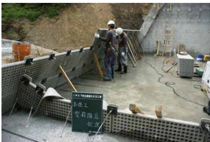
残存型枠による施工状況
