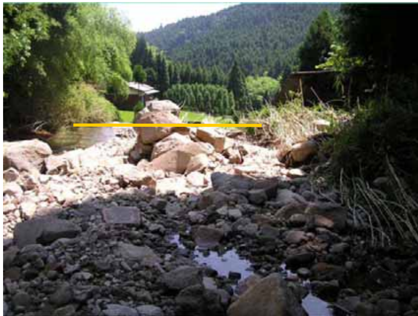
山腹から崩壊した土砂を飯垣内第二えん堤が捕捉
