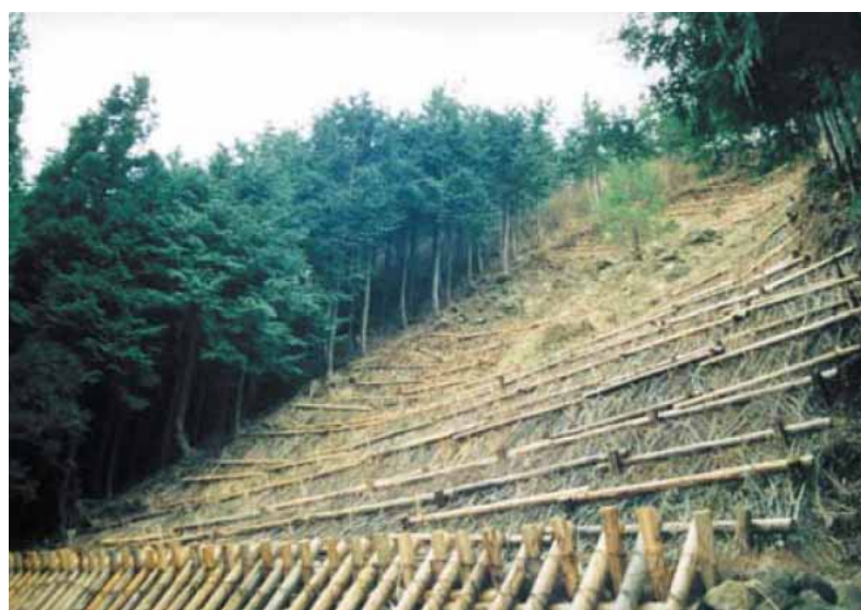
間伐材を用いた節減工法
