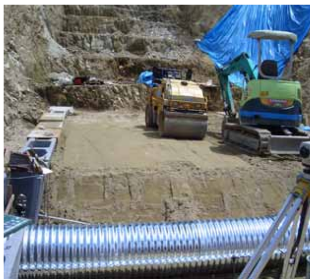
砂防ソイルセメント工法より 稲荷川に建設中の砂防堰堤(滋賀県)
