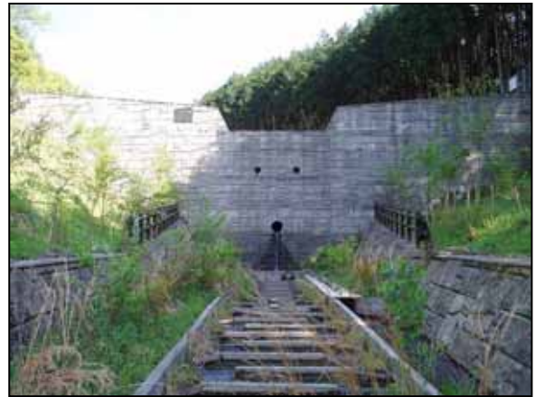
中町大石えん堤 (化粧型枠による修景)
