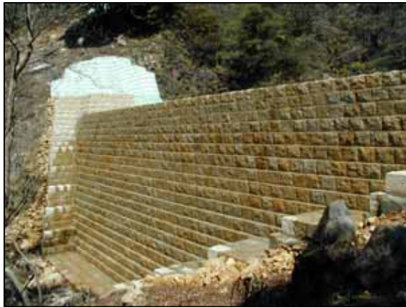
迎不動えん堤 (切石材積みによる修景)
