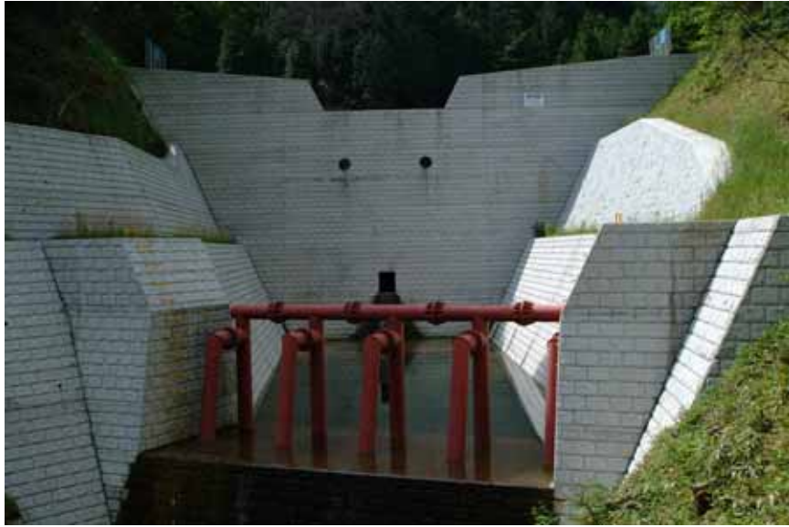
八郎谷2号えん堤 副堤に流木止めを 設置
