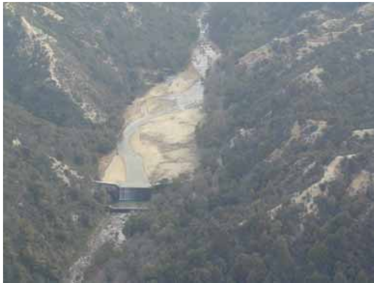
大量の土砂を捕捉した天神川えん堤
