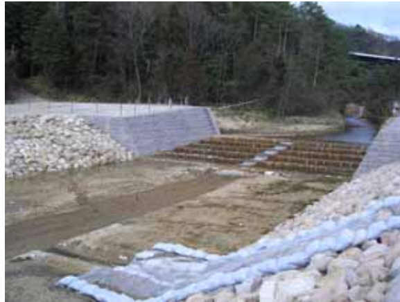
魚道が設置された はやとがわ 準人川溪流保全工
