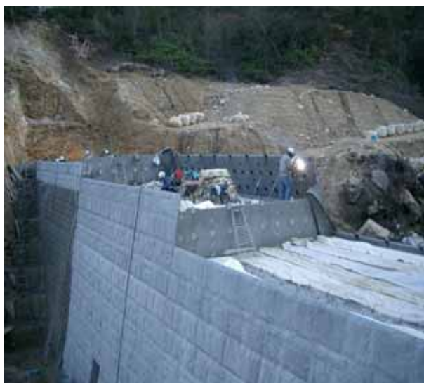
残存型枠を用いた天神川6号えん堤
