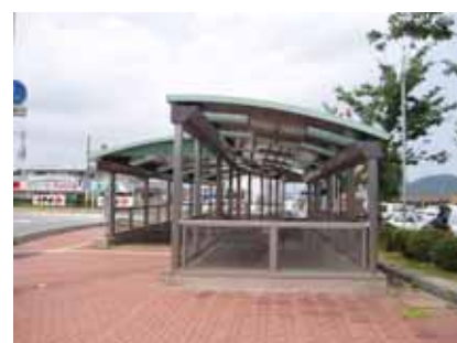
整備された地下横断歩道 (蒲生交差点付近)
