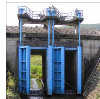
樋門の点検・整備
