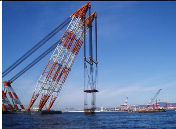
ケーソン移設状況
