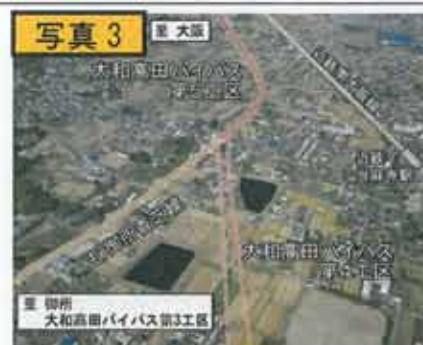
写真③ 葛城市竹内付近（北西を望む） 平成19年11月撮影
