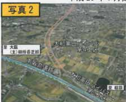
写真② 葛城市辨之庄付近（北西を望む） 平成19年11月撮影
