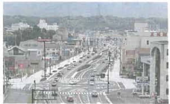
福知山道路4車工事概成区間
