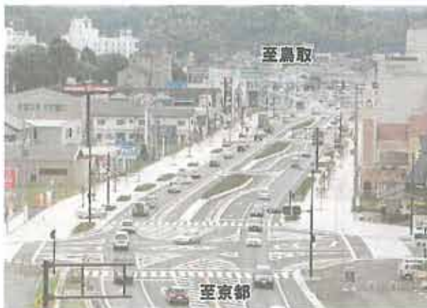
② 4車工事概成区間
