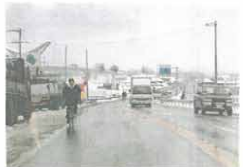
歩道未設置区間の状況
