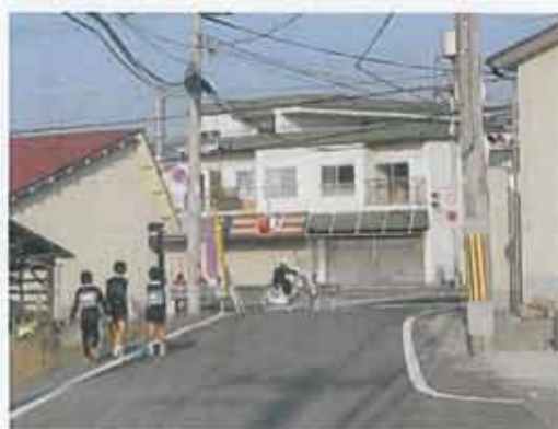
■延伸後の通学路の状況
