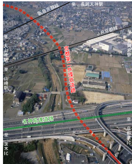
写真②：大山崎 JCT・I C 付近
