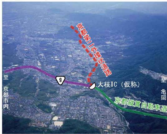
写真①：大枝 I C (仮称) 付近
