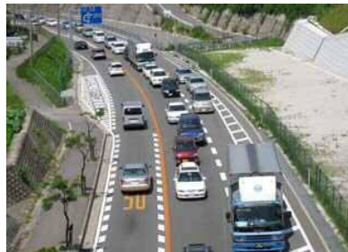
【写真① 上清滝跨道橋より大阪方面を望む】
