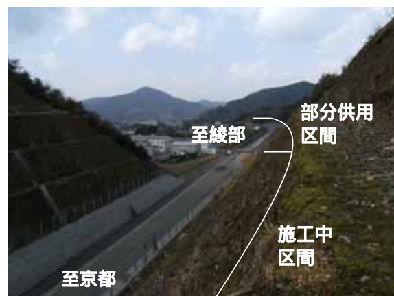
部分供用区間終点付近
