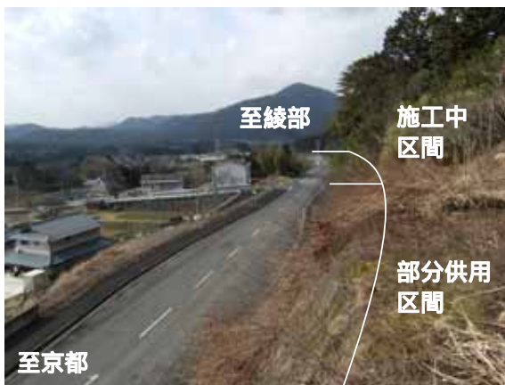
部分供用区間起点付近
