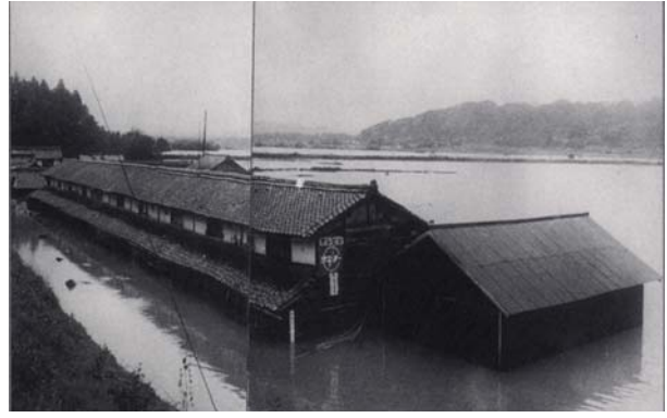
昭和 28 年 13 号台風による 上野市内の浸水状況
