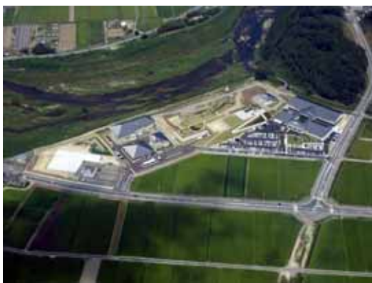
図 5-5 名張川河川防災ステーション
