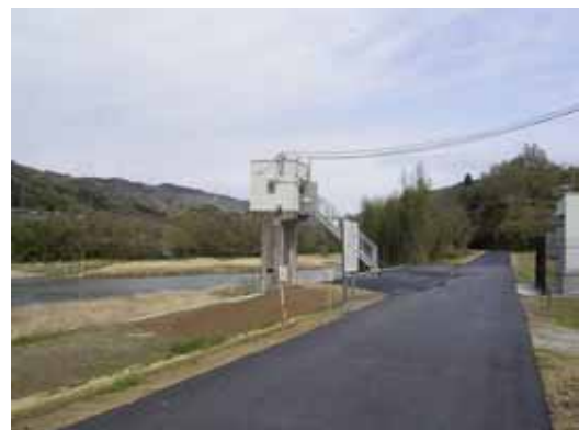
小谷地区改修箇所 （木津川左岸 31.8k 付近）
