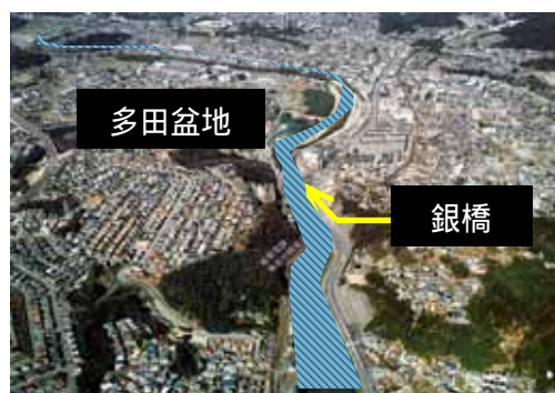
猪名川河道掘削
