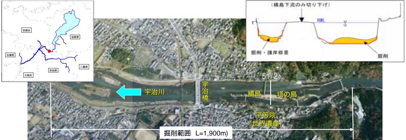
図 5-12 塔の島地区改修
