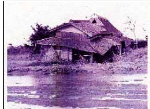
昭和 40 年 24 号台風による 琵琶湖沿岸（守山市）の被災状況
