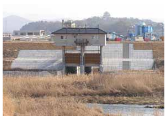
図 5-6 往古川排水樋門
