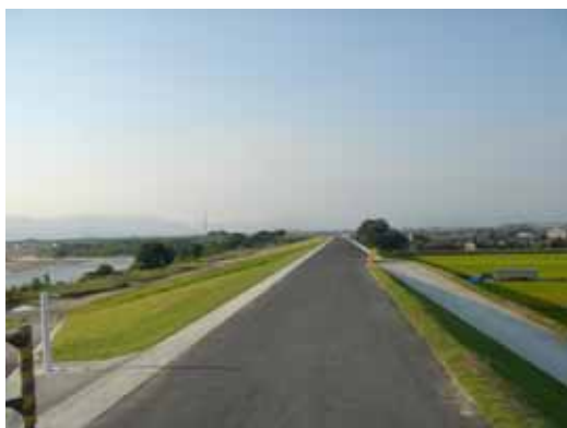
堤防強化対策実施箇所 （木津川右岸 6.5k 付近）
