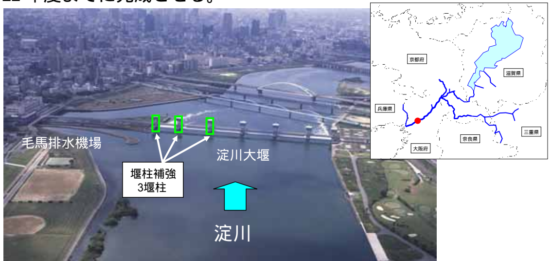
図 5-9 淀川大堰耐震対策箇所
