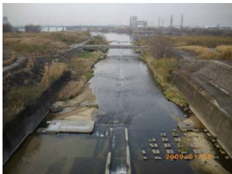
天野川浄化施設
