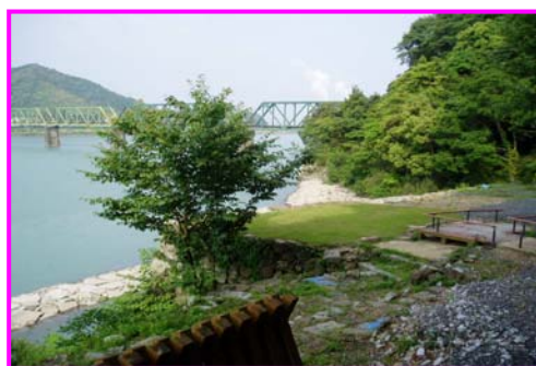
たんかく 丹鶴城周辺の修景護岸整備
