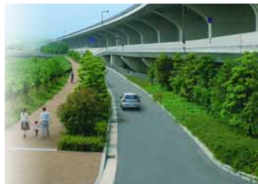
▲第二京阪道路内里地区の歩道
