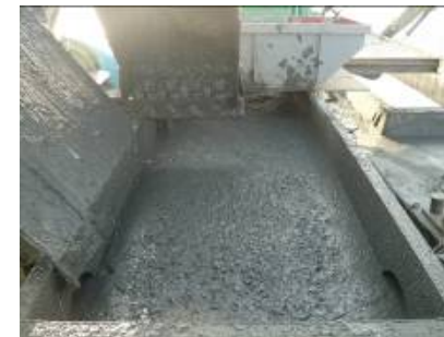
セメントと混合して岸壁裏埋材へ流用
