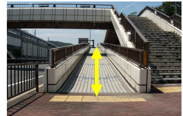
スロープ式歩道橋
