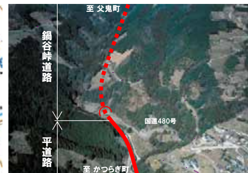
かつらぎ町平地区坑口付近
