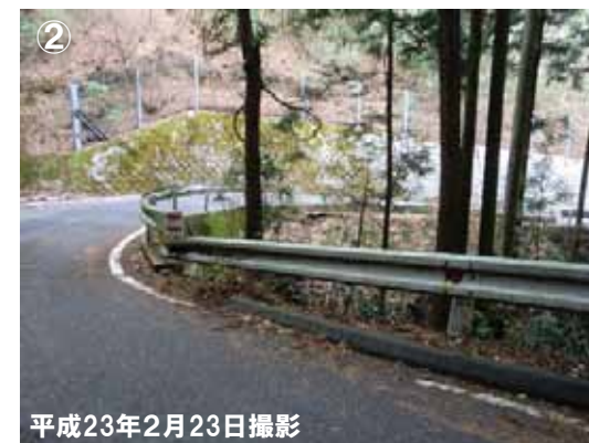
線形不良区間
