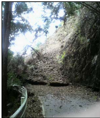
▲土砂崩落の状況
