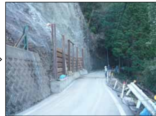
▲仮復旧の状況
