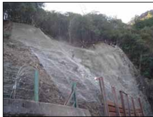
▲法面復旧の状況
