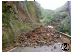
くまのがわちょう たまきぐち 熊野川町玉置口地区で発生した土砂崩落(平成20年1月)
