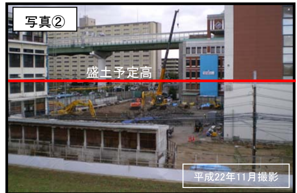
高校新館(低層棟)建設工事の状況
