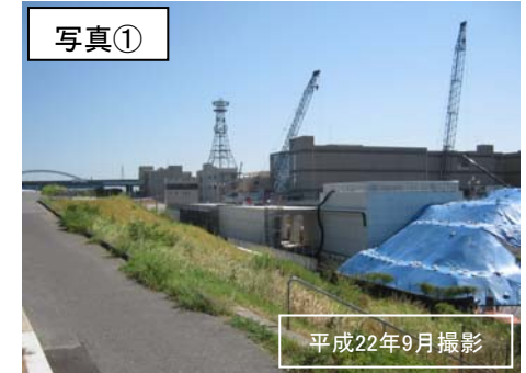
写真① 下流部より整備区間を望む
