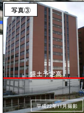
完成した高校新館(高層棟)
