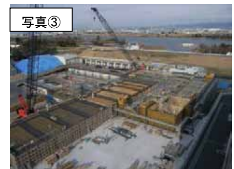
写真③ 躯体工事の状況
