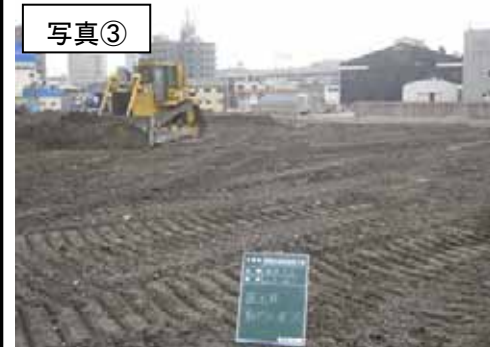
現在の盛土工事中の写真
