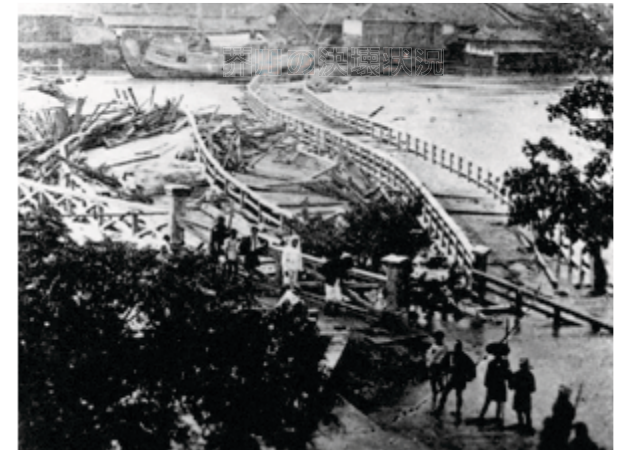
明治18年の安治川橋で、上流から橋梁の木材片が流されて溜まっている状況「大阪市100年」より
