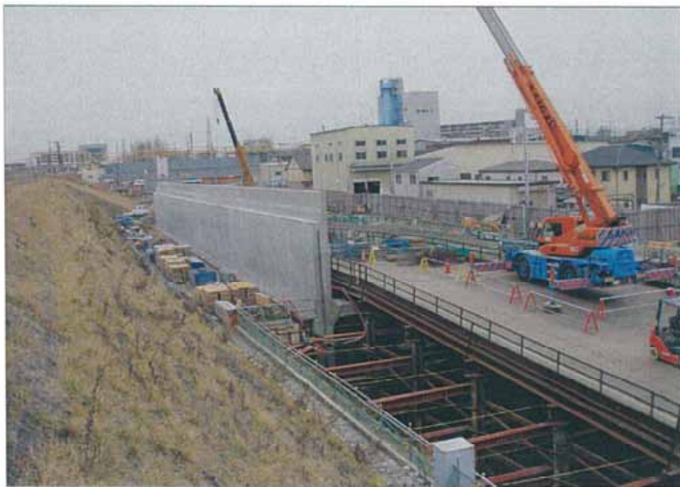
写真4(一部擁壁完了)
