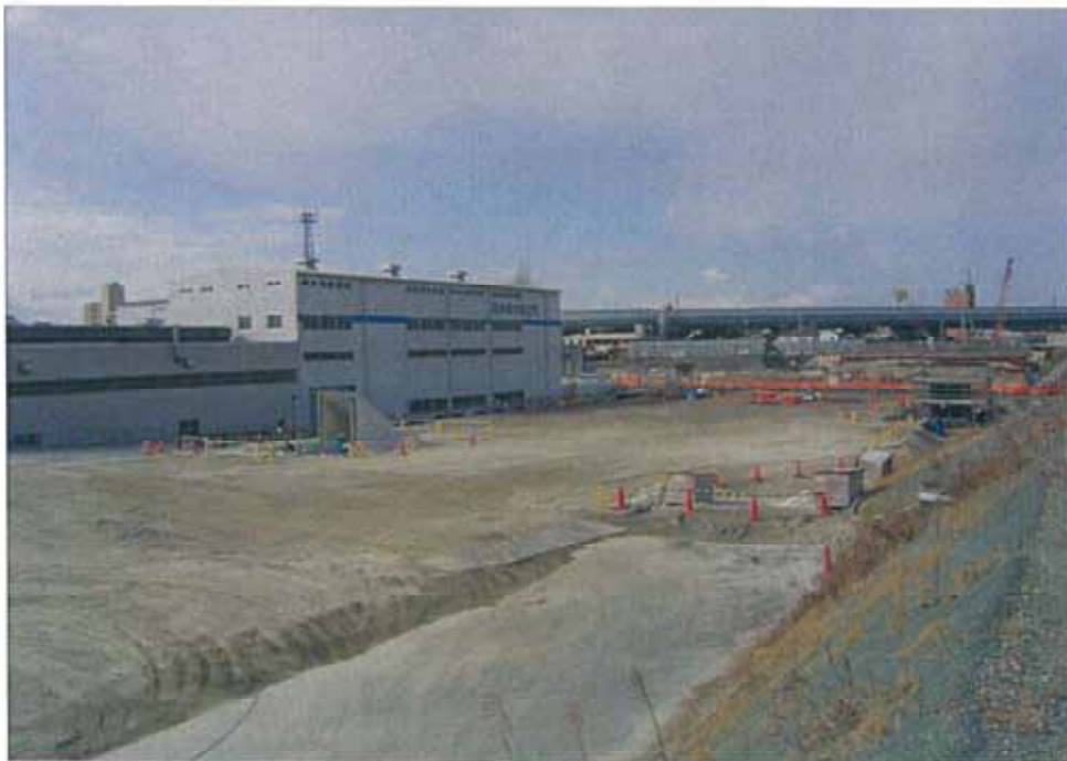
写真2(暫定盛土完了)
