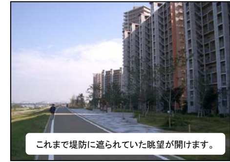
(淀川高規格堤防:伊加賀西地区)
