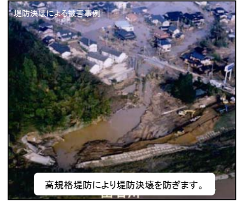
(平成16年台風23号 出石川鳥居橋付近)
