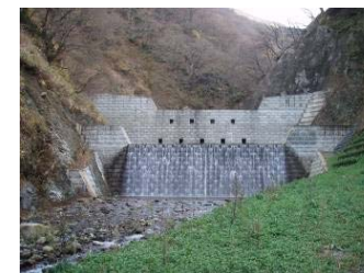
モッカ谷第二えん堤 (平成20年11月完成)
