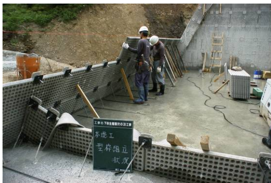
残存型枠による施工状況 (下秋生堰堤) 足場が不要となり、安全な内部での作業となる。
