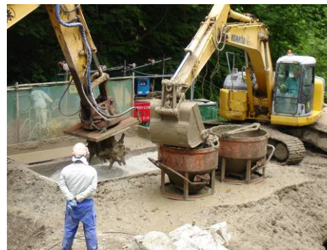
残存型枠による施工状況 (下秋生堰堤) 足場が不要となり、安全な内部での作業となる。
