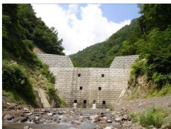
大雲谷第二えん堤 (平成20年11月完成)
