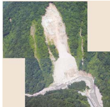
大規模な土砂崩壊 (雲川本川)
