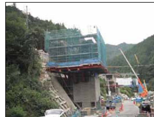
②今戸高架橋上部工事 平成22年9月末撮影
