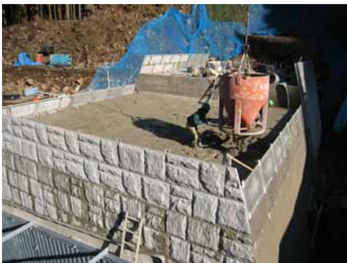
飯垣内第3砂防堰堤
