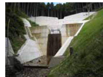
谷出第1堰堤(平成21年度完成)
