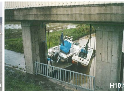
▼洪水時の水位上昇によって樋門に乗り上げ、河川管理上の支障となっているボート
