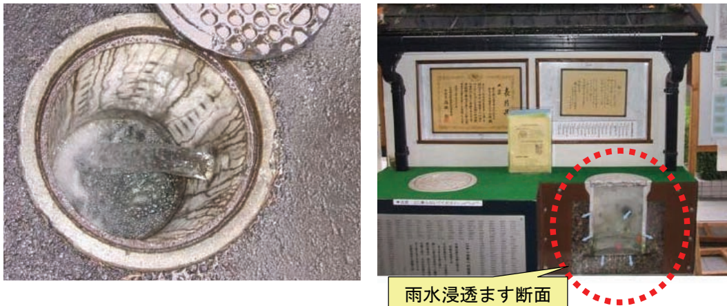
雨水浸透ますの例 (「雨水浸透施設の整備促進に関する手引き(案)」より)
