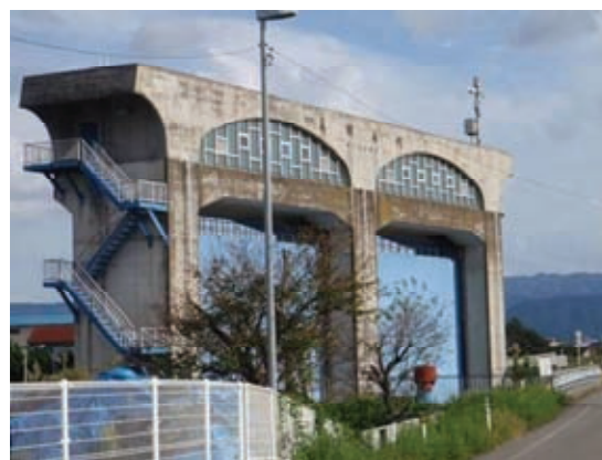
荒川水門(足羽川右岸4.6k付近)
