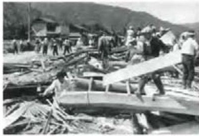
上志比村(現永平寺町)の被災状況
