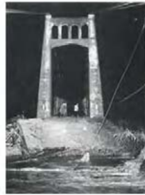
鳴鹿橋の流出
